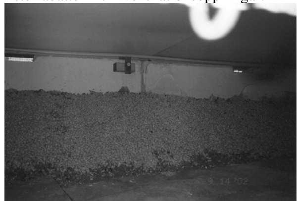
Figur 1.2 - Kanterna runt kryppgrunden cementslammades för att stabilisera dessa.
